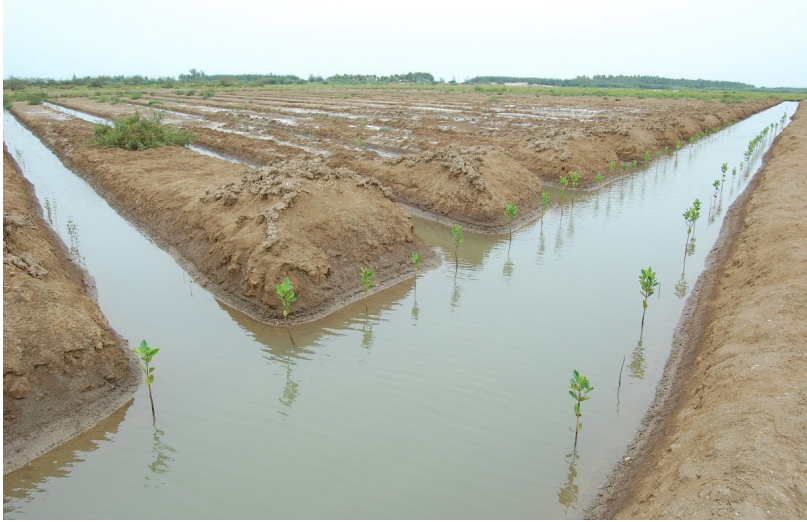
படம் 3: நீர்குழிவையியலை (hydro-ecological) அடிப்படையாக கொண்டு அழிவுற்ற கண்டல்காடுகளை மீட்டுவாக்கம் செய்ய அமைக்கப்பட்ட கால்வாய்கள்
